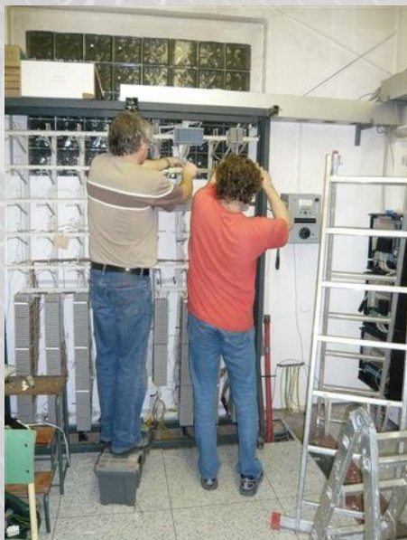
Práce na finálním přepojování.
