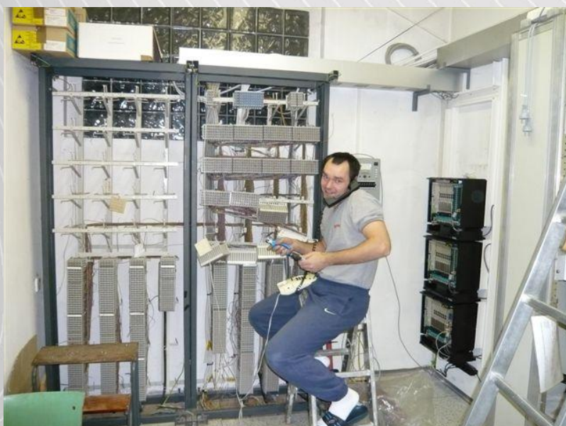
Práce při mapování rozvodů stávajícího zařízení.
