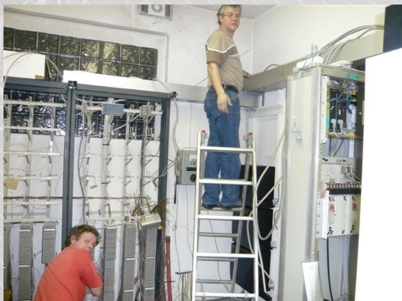
Přípravné práce na přepojování.
